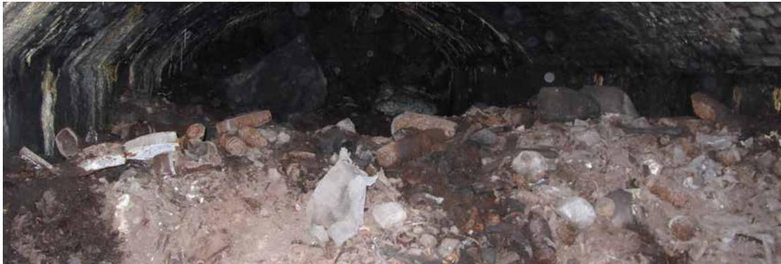
*Blick in einen nicht eingestürzten Stollenbereich mit durch die Explosion hineingeschleuderten Munitionsartikeln.*
